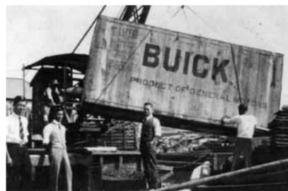
1923(大正12)年、芝浦工場に陸揚げされるビュイック。外国車の輸入は、体積を小さくするためにパーツごとに分解され輸入されていた。リムジン型の完成車は一台ずつ箱詰めされていたが、ボディはヤナセで製作取り付けを行なった
