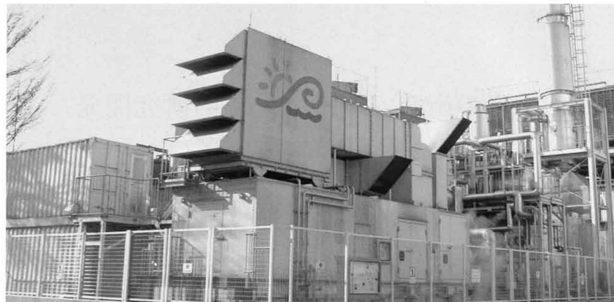
生産領域でのCO 2 排出抑制のため埼玉製作所に導入された、天然ガス・コージェネレーションシステム
