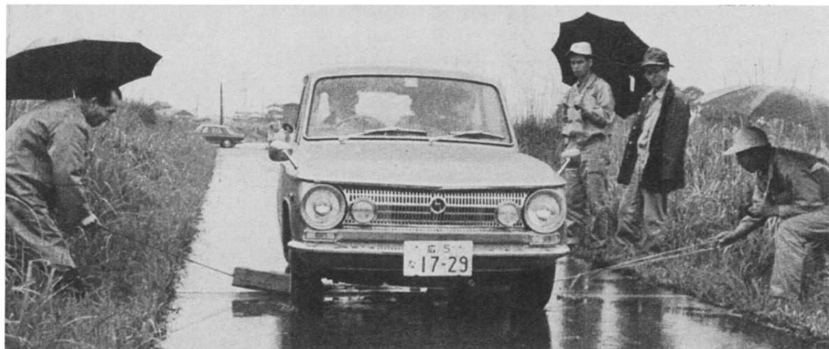
亘理研究室「振動乗り心地試験」風景、モーターファン誌主催のロードテスト(機械試験所東村山テストコース・1964年6月)
