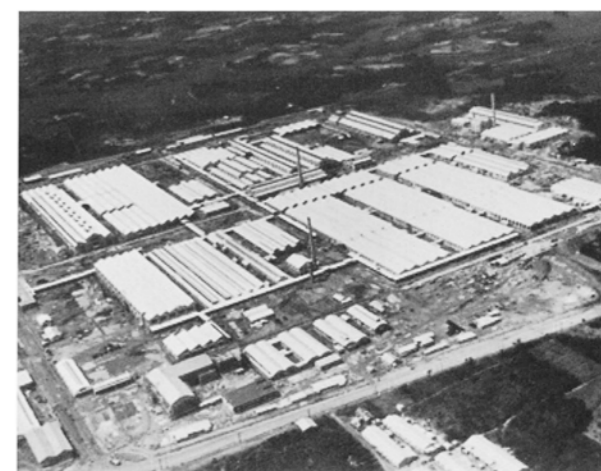
建設当初の挙母工場(現本社工場)
