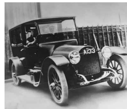
後期の量産改良型。ボンネット形状が変わり、バッテリーとヘッドランプを装備。ナンバープレートで三菱マークの有無が不明。
